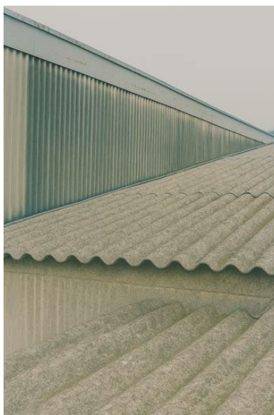
Figura 6 - copertura esterna con lastre in cemento amianto
