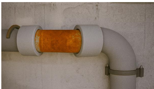
Figura 9 - condutture in cemento-amianto
