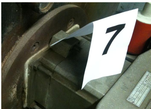
Figura 34 - guarnizione locale caldaia
