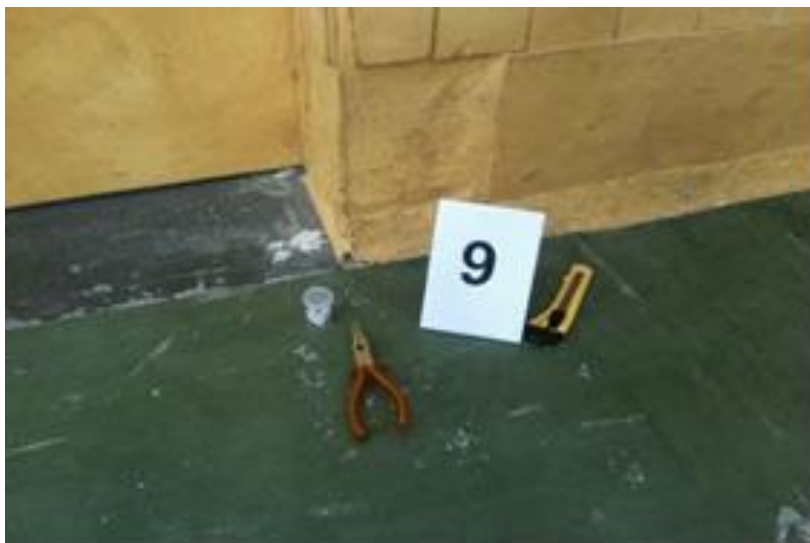
Figura 33 - pavimentazione vinil-amianto
